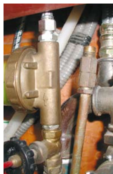
Returrør ikke afblændet.
