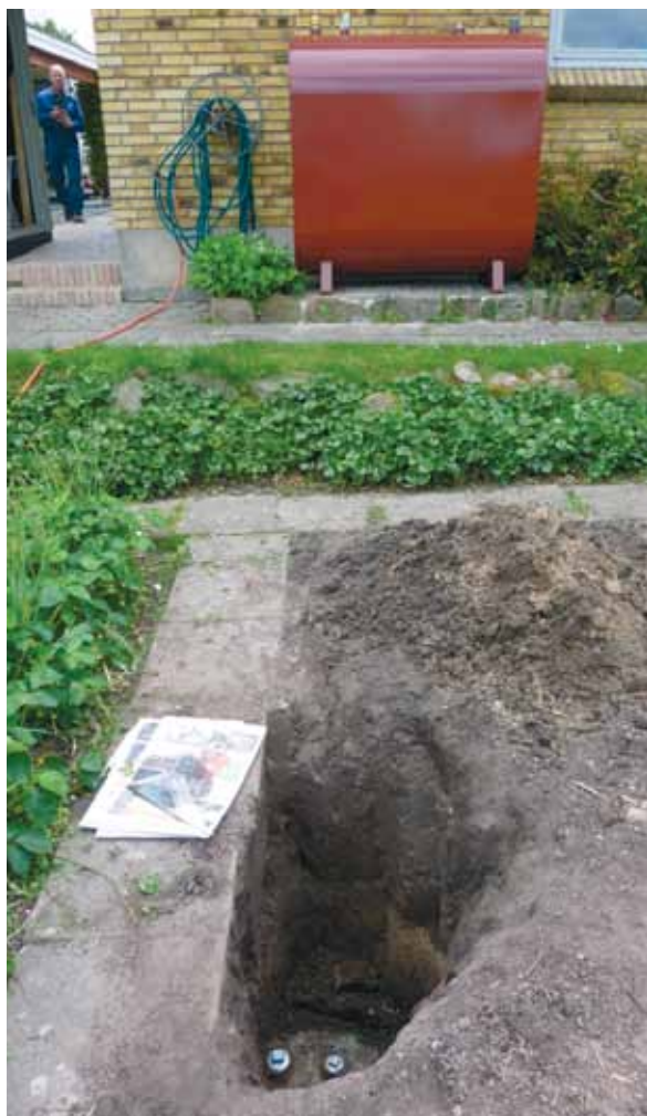
Sløjfet nedgravet tank, bundsuget og aflændet.
