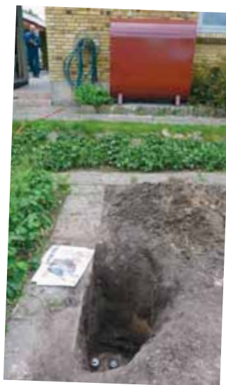
Sløjfet nedgraved tank, bundsuget og arblændet.
