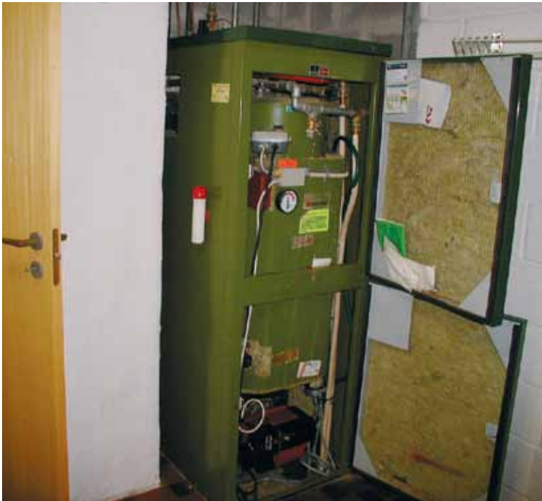
Den nye energiefteftersynsordning lægger op til kun at gælde oliekedler, som denne typiske kedel fra omkring 1980.
